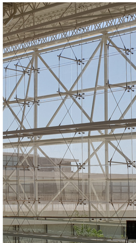
SISTEMA F14V- ROD F14V-ROD SYSTEM
