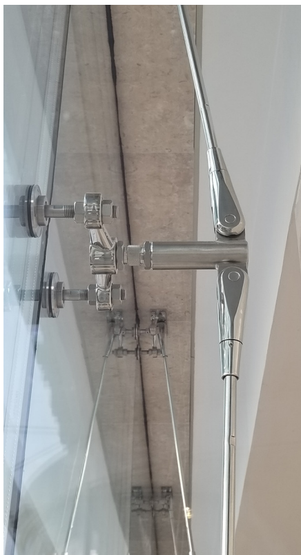
SISTEMA F12H- ROD F12H-ROD SYSTEM
